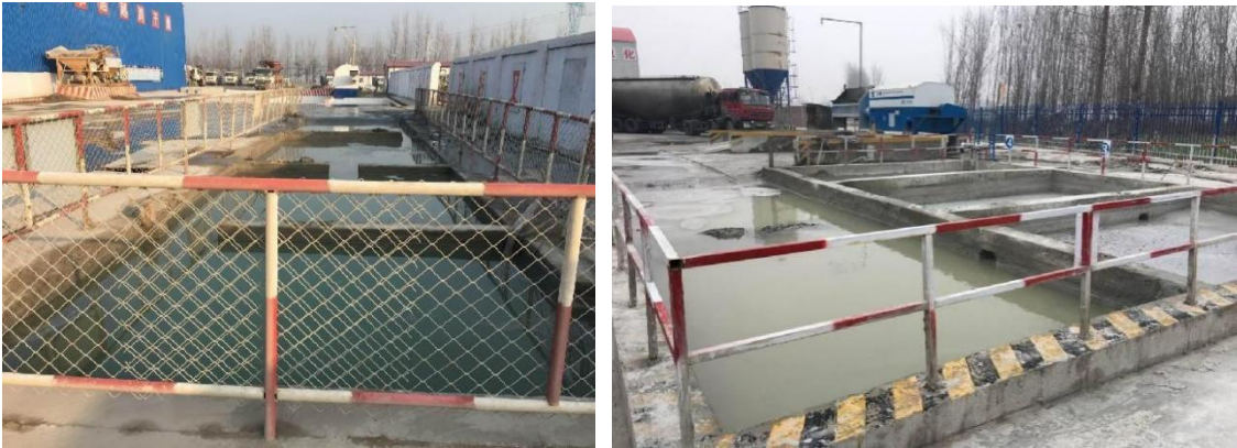
图 8.5-3 梁场、拌合站等施工场地沉淀池照片
