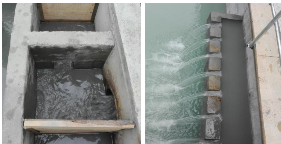
反应池进水口反应池——沉淀池
