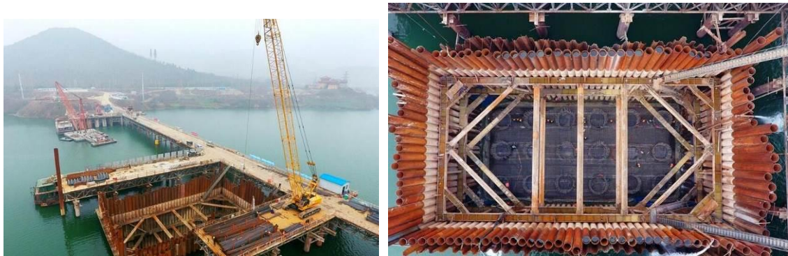
图 8.4-5 钢围堰施工照片
