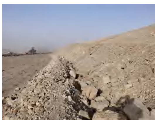
排土场边坡压盖第四系松散砂岩层
