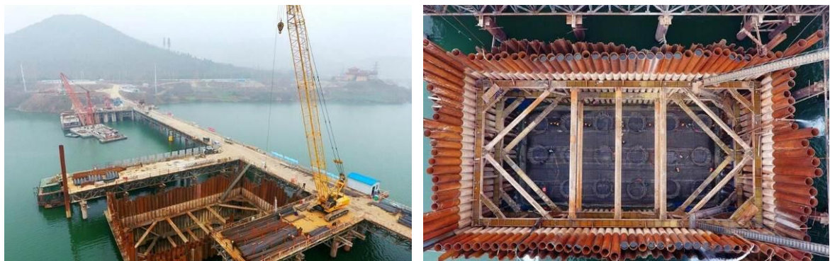
钢围堰施工照片（河流水质扰动小）
