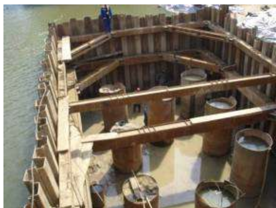
桥梁施工钢板围堰
