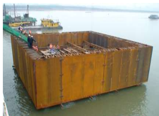
钢围堰拼装完成
