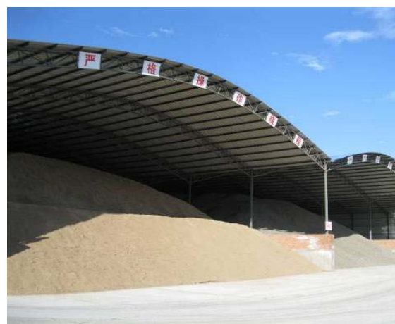
图 4.3-13 拌合站中砂、碎石密闭存放
