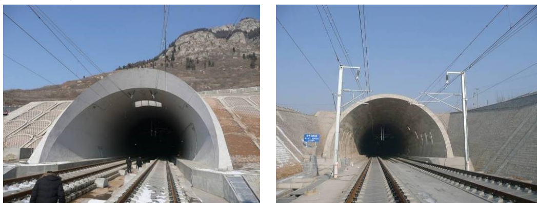
图 5.4-1 隧道洞口缓冲结构图
