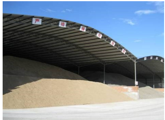
图 4.3-11 拌合站中砂、碎石密闭存放
