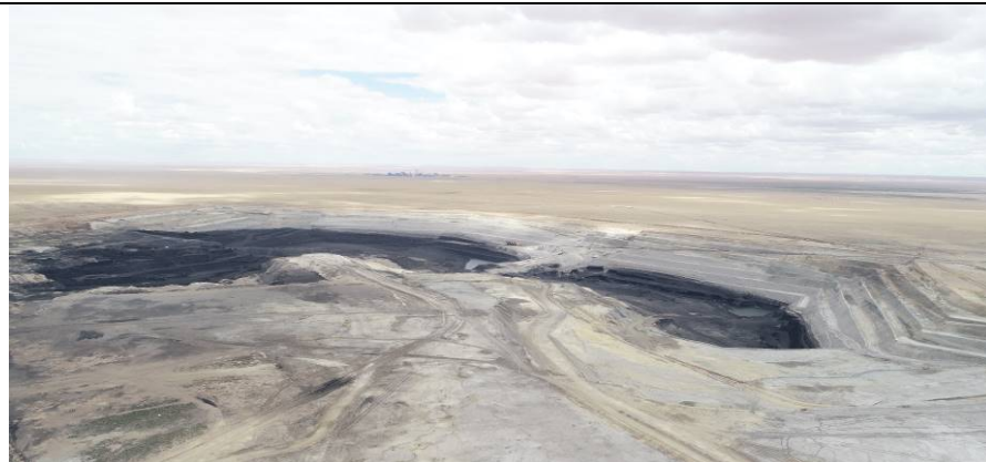
采掘场内排土场现状
