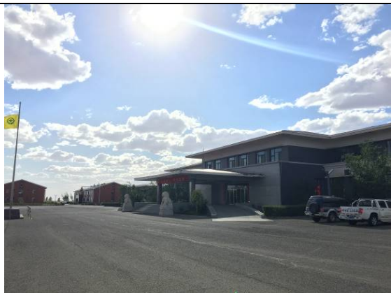
工业场地内办公楼
