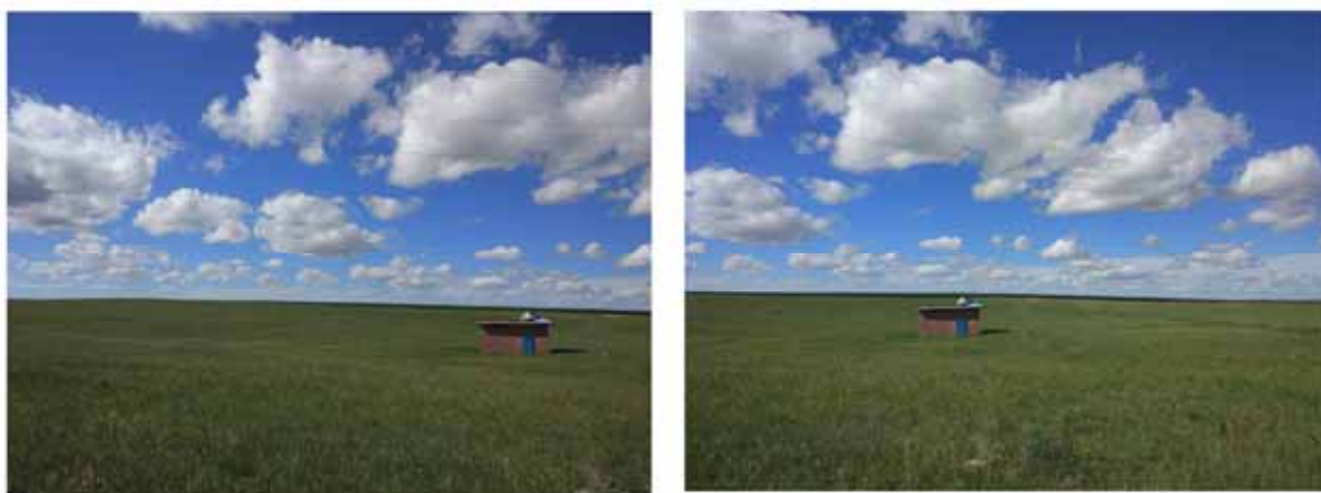
图 5.3-1 蒙西煤矿沉陷区现状
