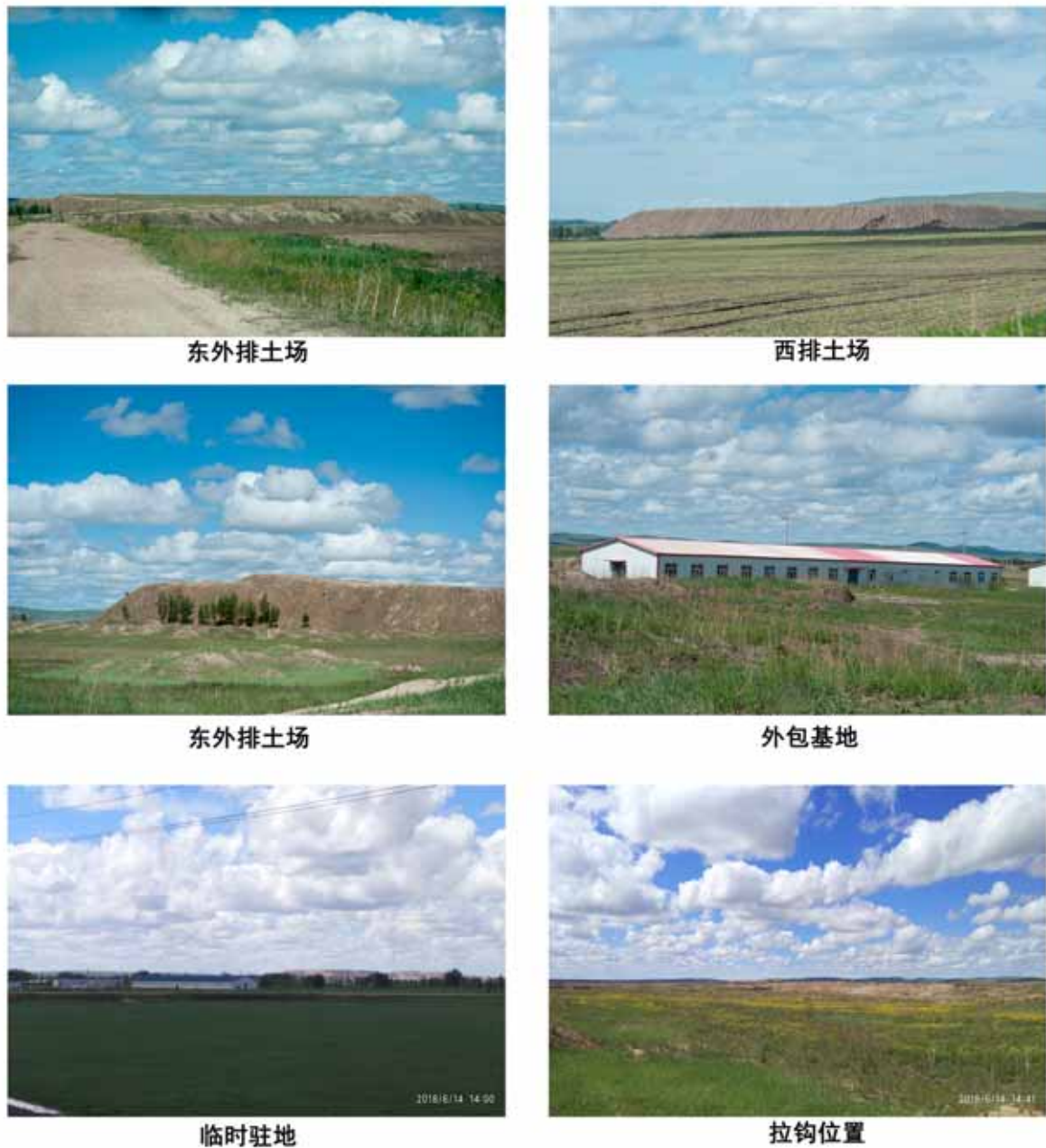
图 2.4-2 施工现场现状图
