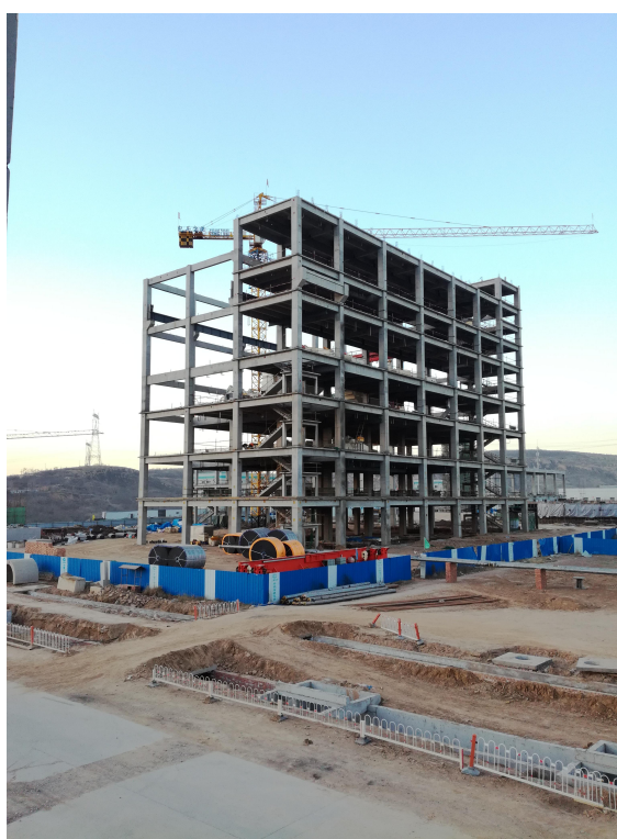
选煤厂主厂房
