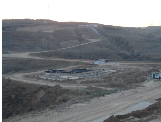
生活污水处理站
