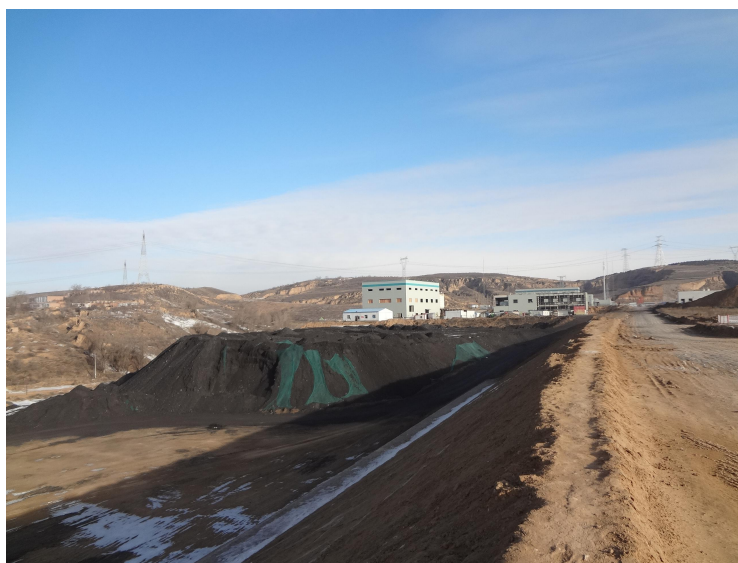
工程煤堆堆放情况
