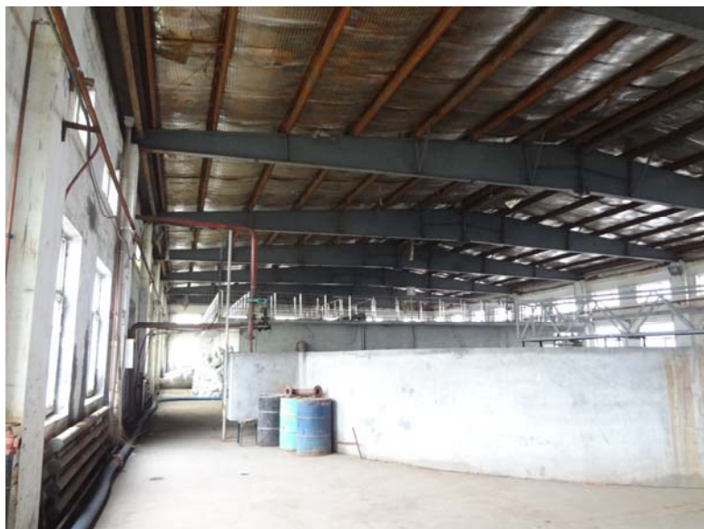
图 7.4-2 生活污水处理站
