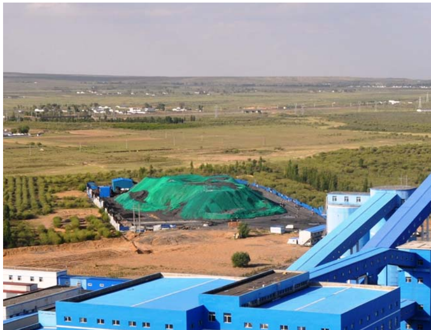
图 6.3-2 临时工程煤堆
