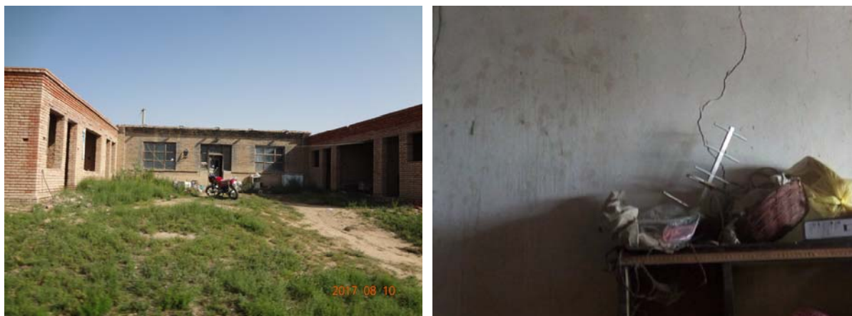
图 3.2-2 瓦窑社首采工作面影响范围剩余未搬迁户房屋及裂缝情况
