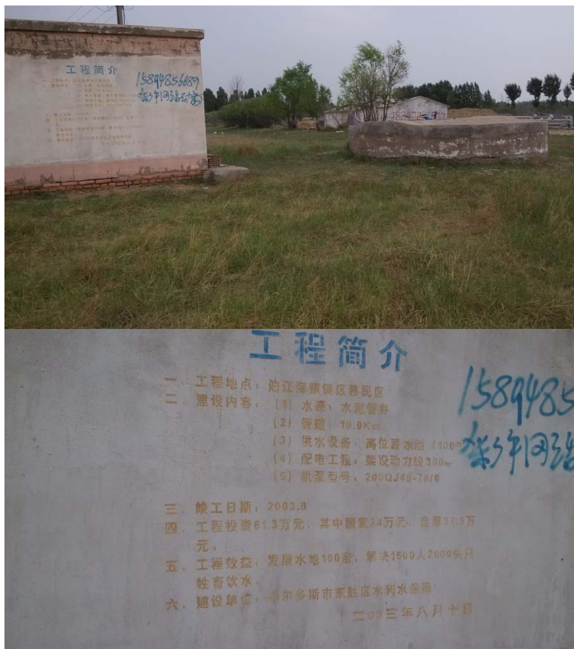
图 5.3-1 泊江海子供水井—紫蛇渠水源地照片
