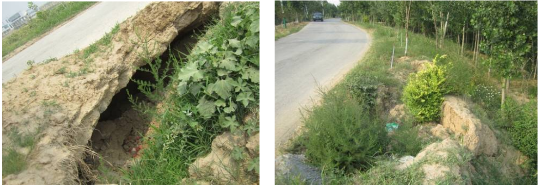
堤坡溜沟现状
