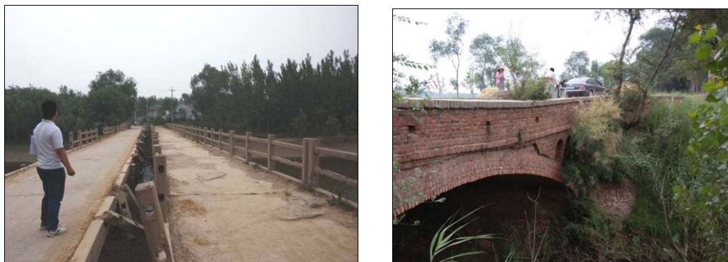
退排水河道上桥梁现状
