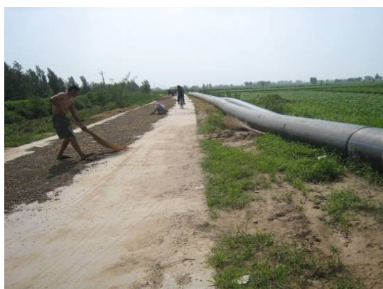
县城围堤现状
