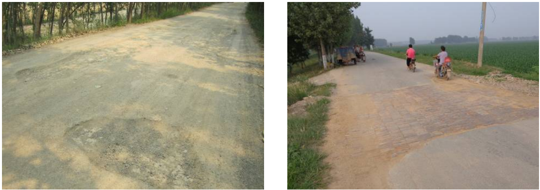
堤顶道路现状
