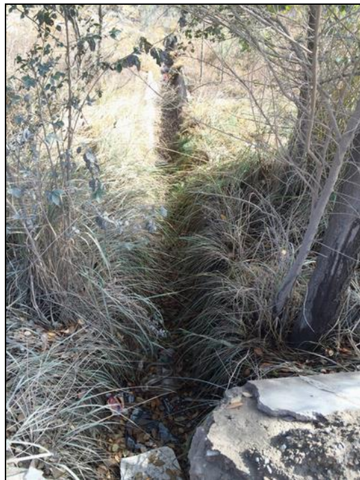
甘肃省中川增雨基地现状排水边沟
