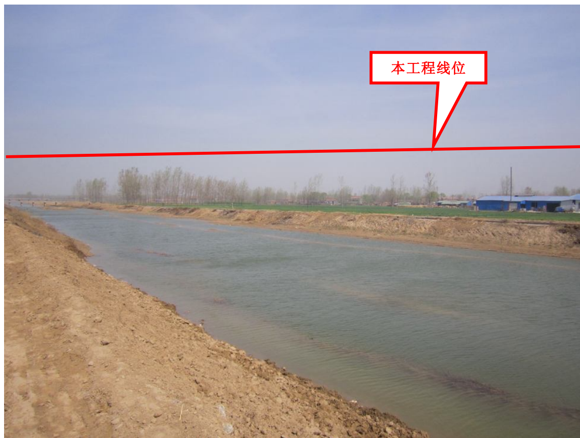
图 7.5-1 工程跨越引黄渠处现状图
