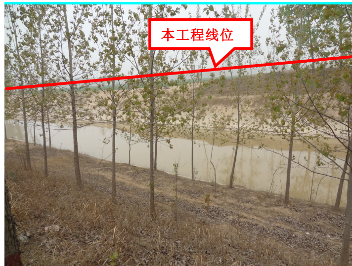
图 7.5-4 跨越商丘干渠东分干渠处现状图
