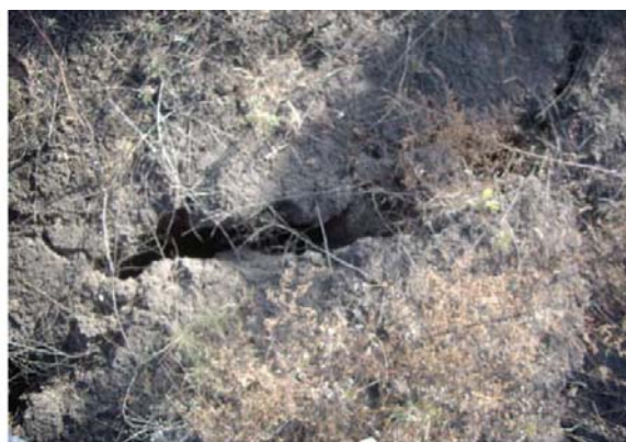
沉陷形成的地表裂缝
