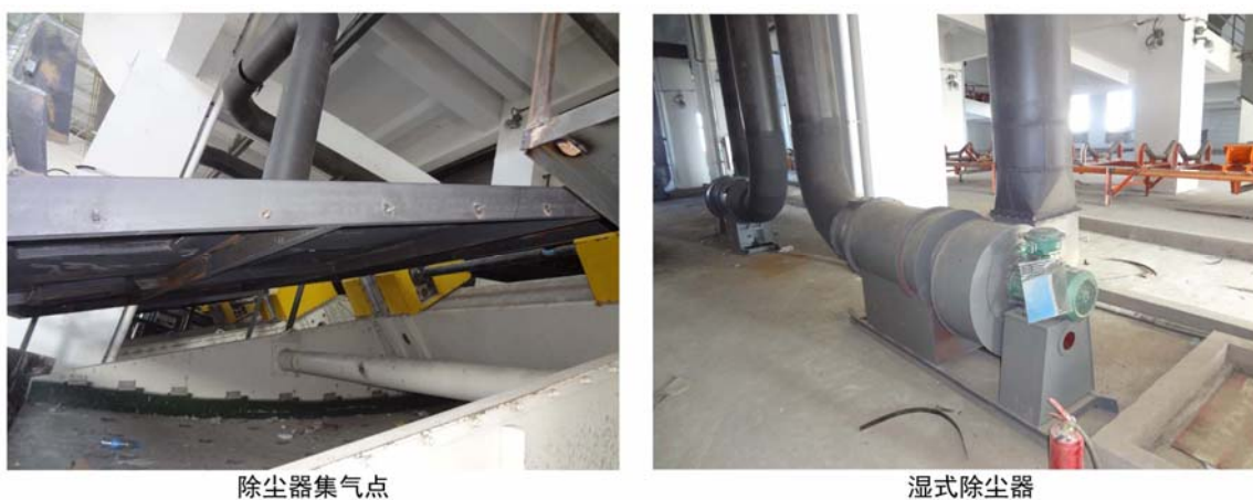
图 7.6-2 选煤厂除尘器建设现状
