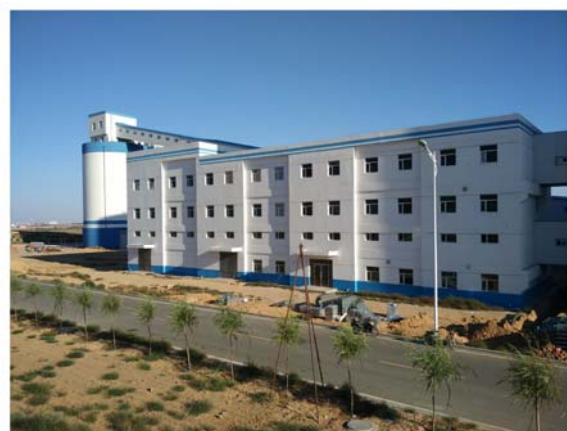
选煤厂综合办公楼
