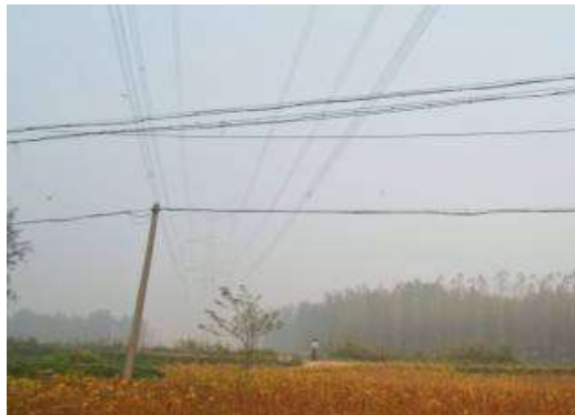
照片 6.2-1 500kV 颍州~阜二变线路声环境影响监测现场情况
