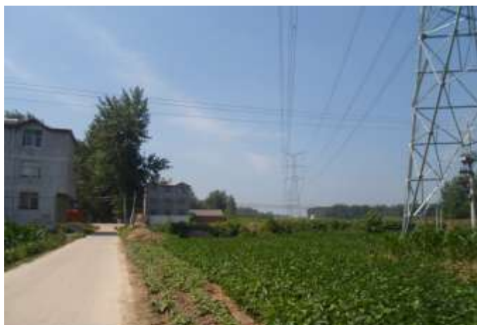
图 6.1-1 500kV 颍州~阜二变线路电磁环境影响监测现场情况
