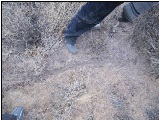
照片 1 L1 地表裂缝
