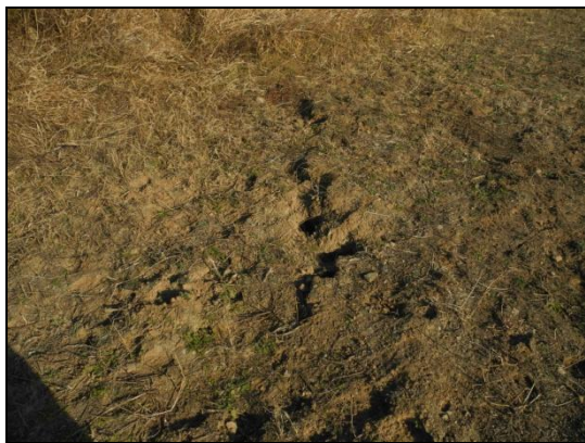
照片 3 L3 地表裂缝
