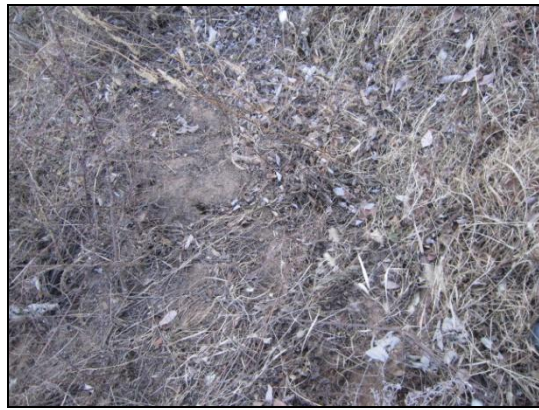
照片 2 L2 地表裂缝
