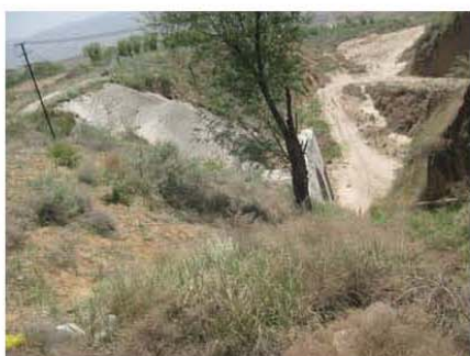
薛魏公路隧道
