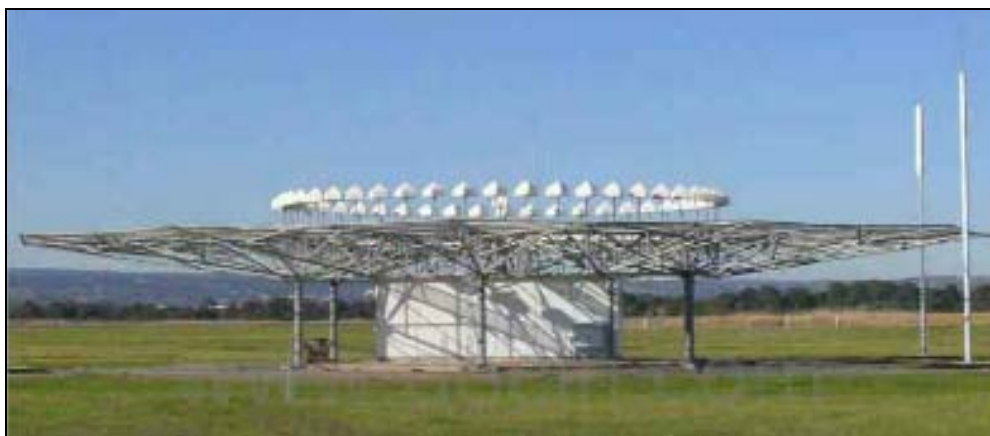
图片说明：DVOR 常与测距机(DEM)信标合装在同一站台，图中圆周上布置的天线为 DVOR 天线，旁边直立的有一个是 DEM 信标天线
