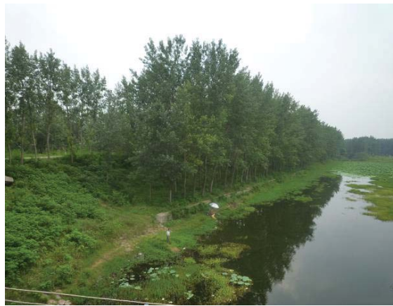
图 16 纸坊闸堤防护坡实景
