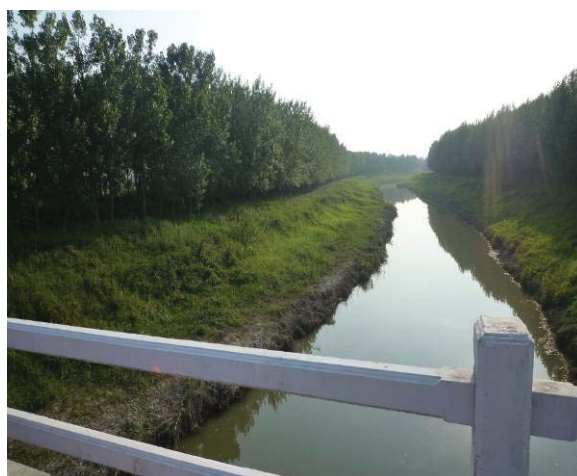
图 6 老王坡滞洪区部分河段实景
