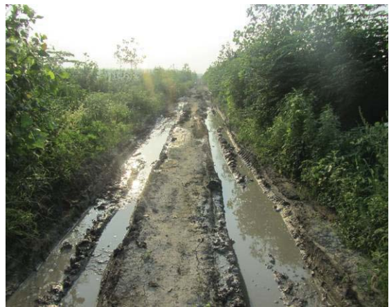
图 10 汝河右堤顶实景
