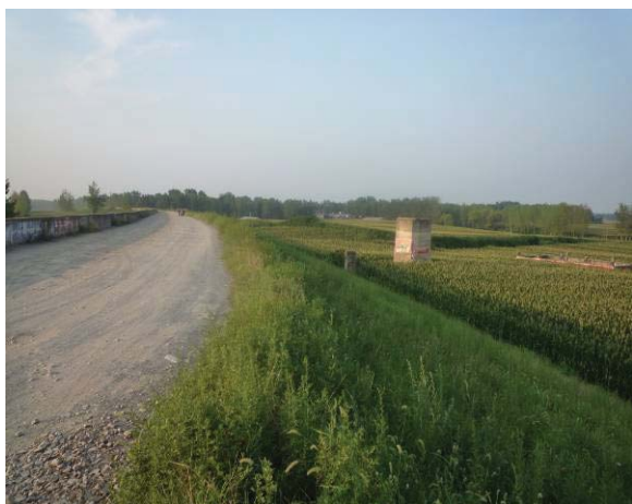
图 7 杨庄大坝北岗段实景
