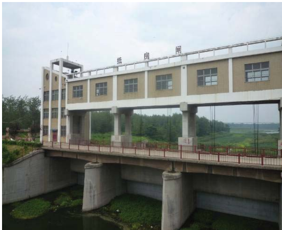
图 15 纸坊闸工程实景
