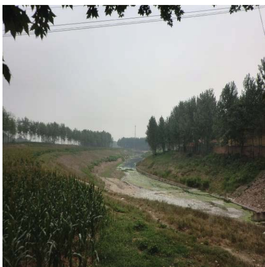
附图 20-1-5 干河堤堤顶道路周边植被环境
