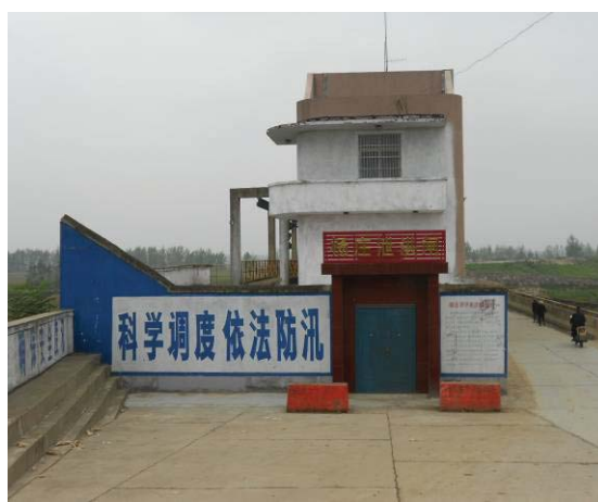
图 8 杨庄滞洪区泄洪闸实景
