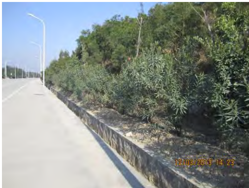
图 5.3-2 进厂道路防护林及边沟
