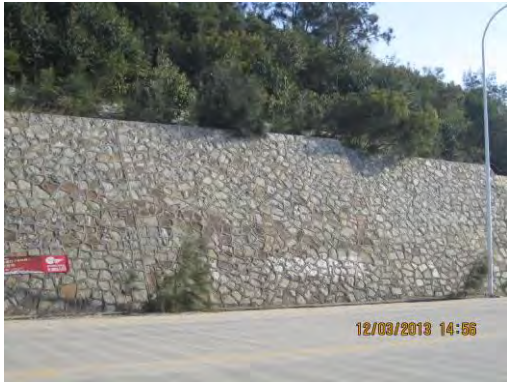
图 5.3-1 进厂道路浆砌石护坡工程
