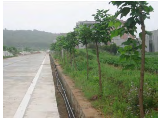
图 5.3-4 应急道路防护林及边沟
