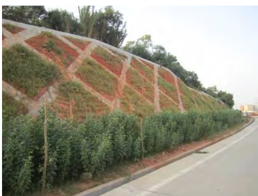
图 5.3-3 应急道路边坡植草防护
