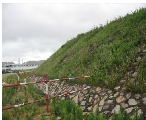
图 5.3-9 气象站后边坡防护
