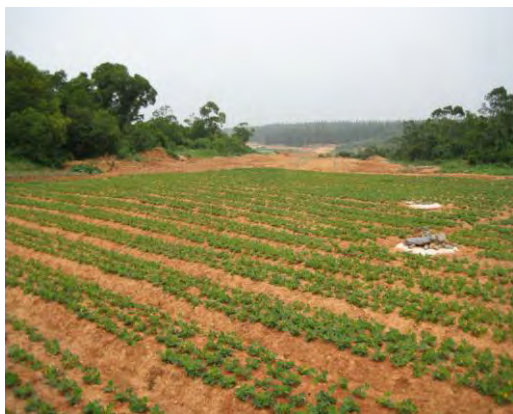
图 5.3-7 供水管线复耕
