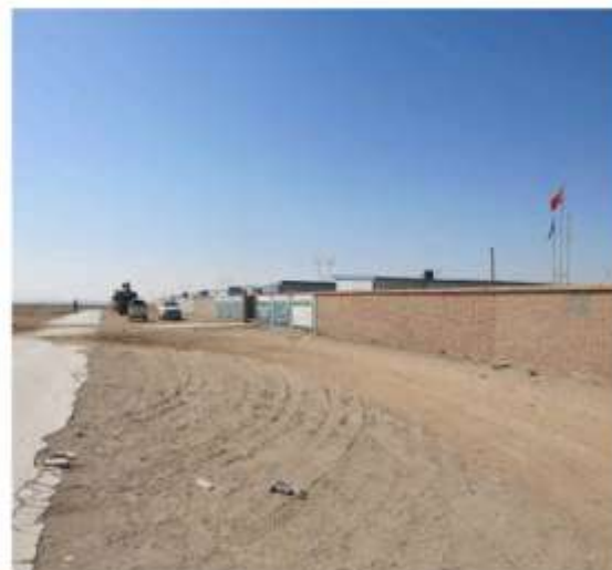
一期工程临建
