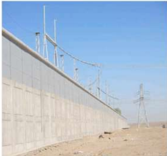
直流线路及接地极线路终端
