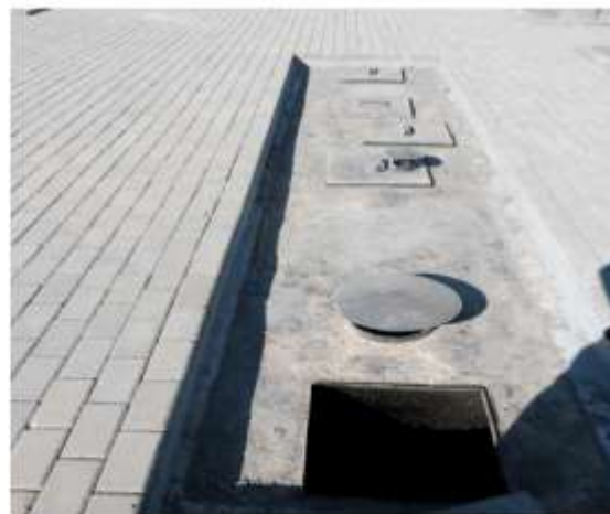
站内生活垃圾外运
