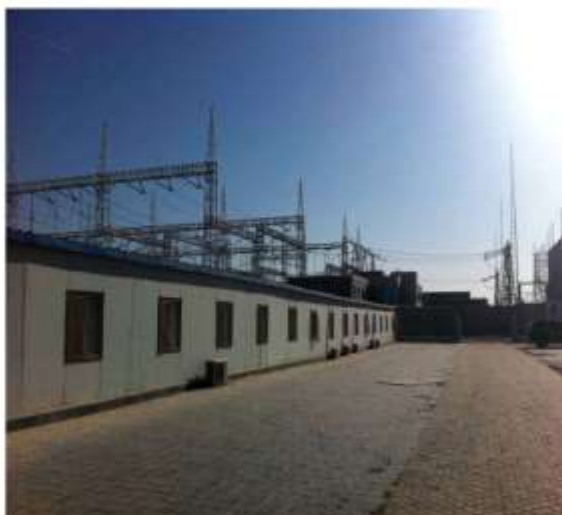
一期工程临建
