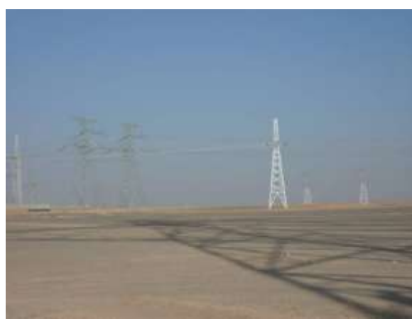
4.1-2 输电线路沿线戈壁荒漠
