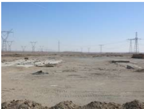
4.1-1 换流站北侧扩建场地
