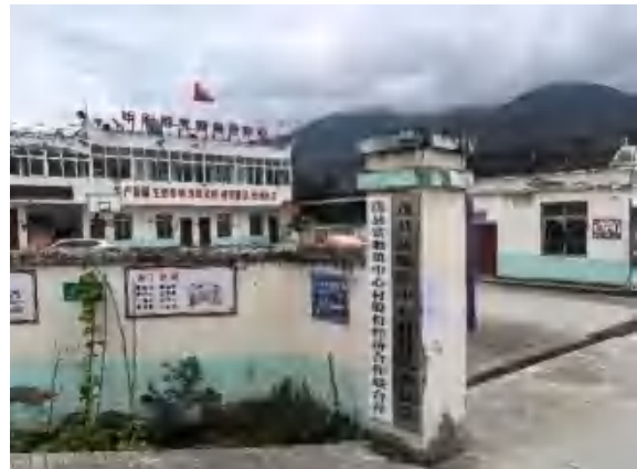
阿坝州茂县富顺镇中心村
