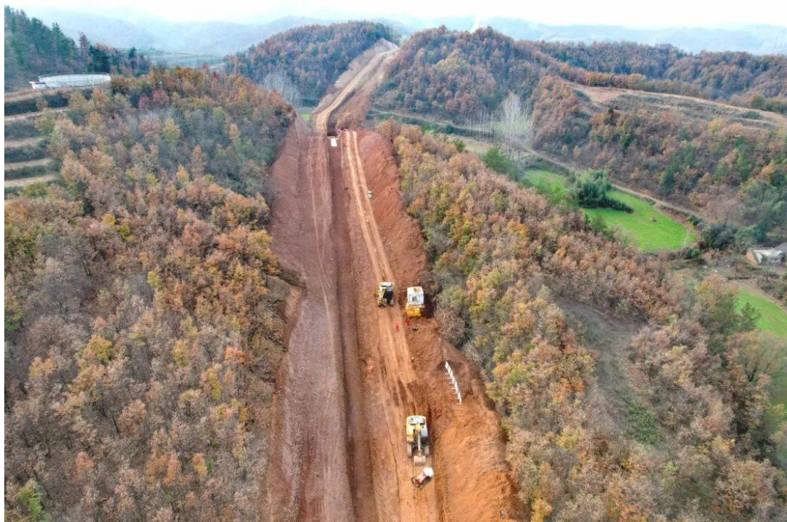
图 4.1-2 国内同类工程管沟开挖实景图片
