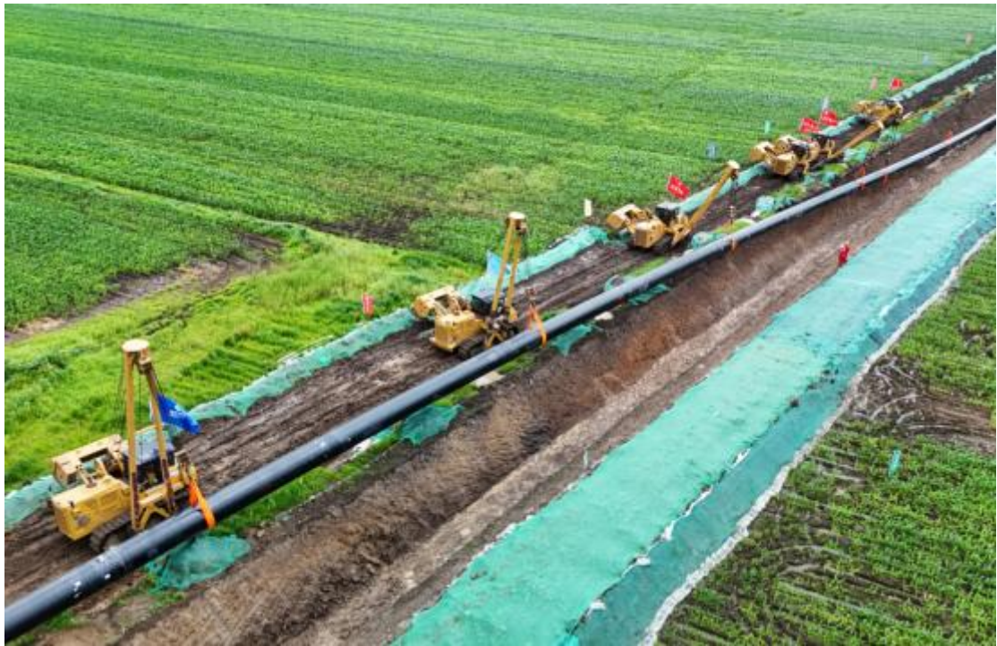
图 4.1-3 国内同类工程管道下沟实景图片
