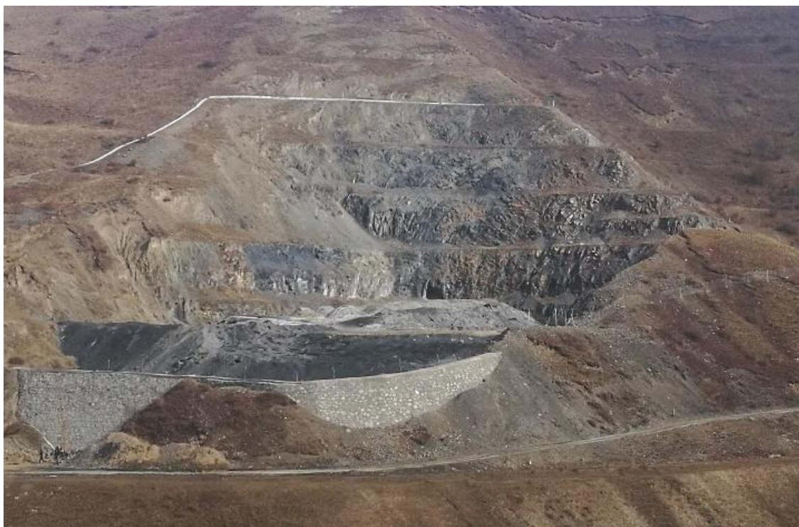
图 6.2-2 104 露天坑尾渣库挡墙（安全整治前）
