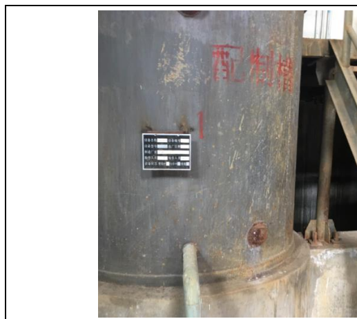
图 5.5-19 淋洗剂配制槽
