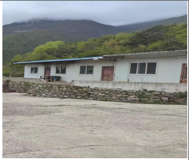
康定站址北侧闲置空房
