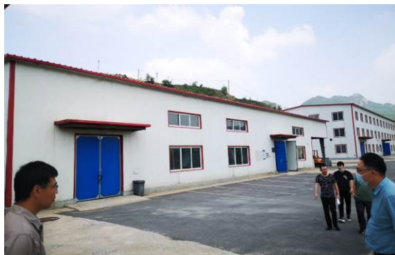
图 3.1-1 矿坑水预处理厂房
