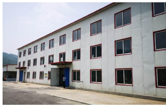
图 3.1-2 矿坑水铀回收厂房
