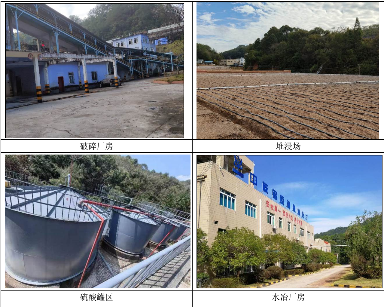
图 3.1-1 锦原公司水冶相关设施现状
