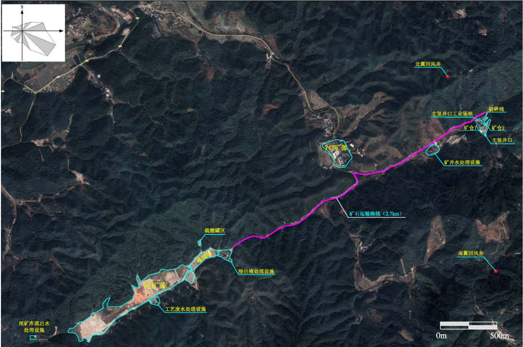
图 3.1-4 现有生产设施及废物处置设施现状
