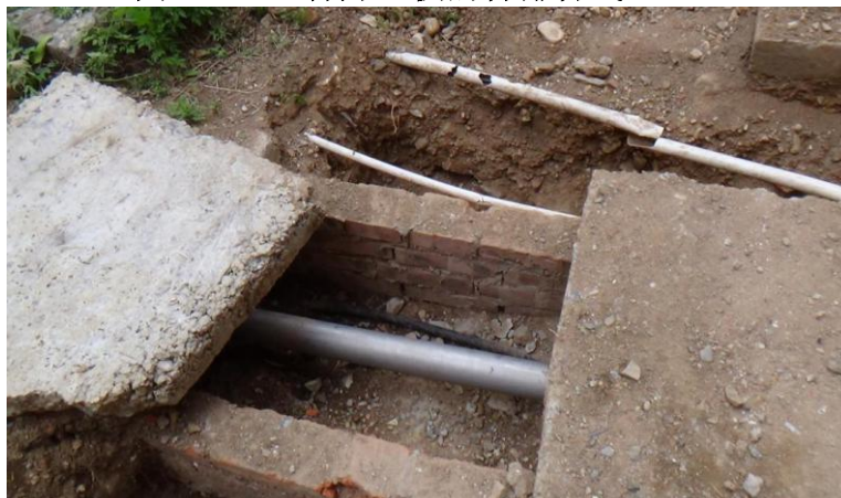
图 3.2-2 已打开盖板的特排管线（二）
