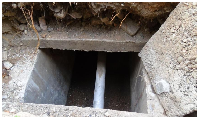
图 3.2-1 已打开盖板的特排管线（一）
