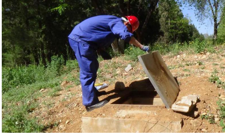
图 3.2-3 检查井排查情况（一）
