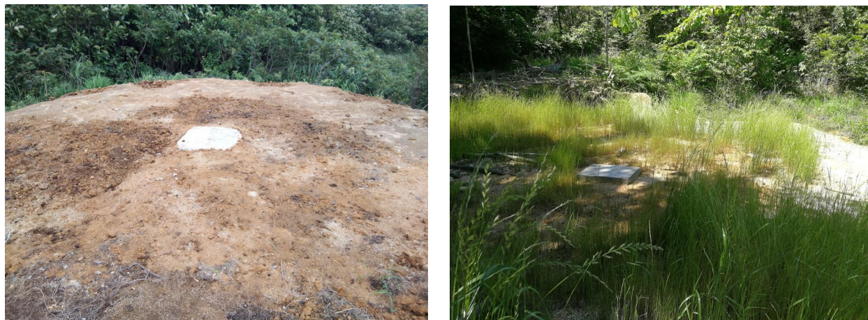
图 1-2 钻机机坪施工期照片及恢复期照片
