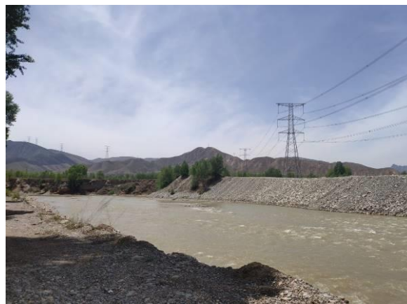
线路跨越大通河现状
