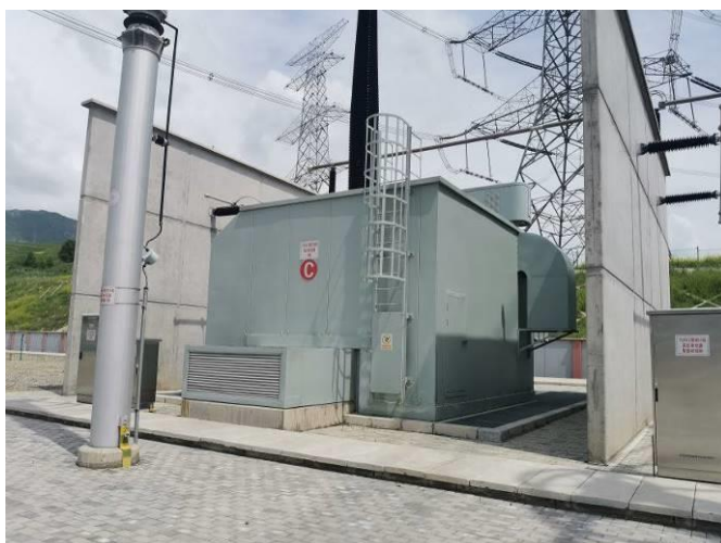
图 3.8-1 750kV 变电站典型噪声控制措施实例
