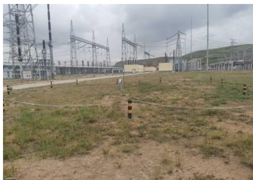
主变事故油池
