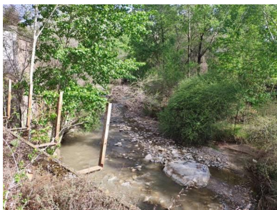
线路跨越引胜沟现状
