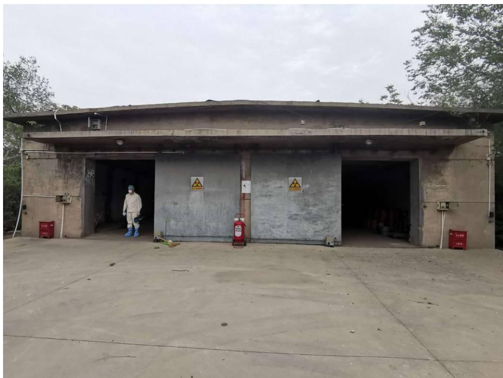
图 1-2 放废库库房外观图
