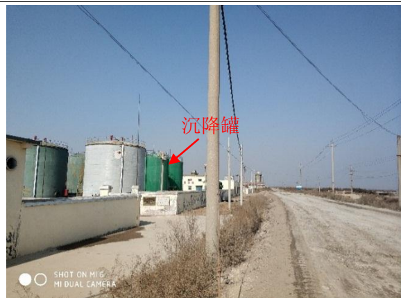
沉降罐（角四接转站）
