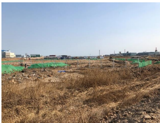
临港变电站（正在施工中）
