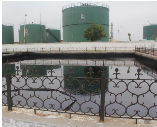
海四联合站油气处理设施
