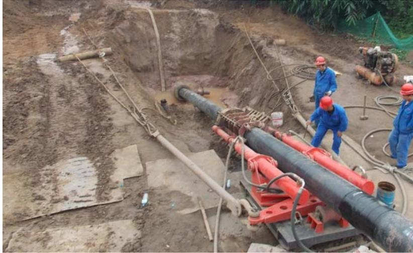
图 2.3-6 保护套管发送方式示意图
