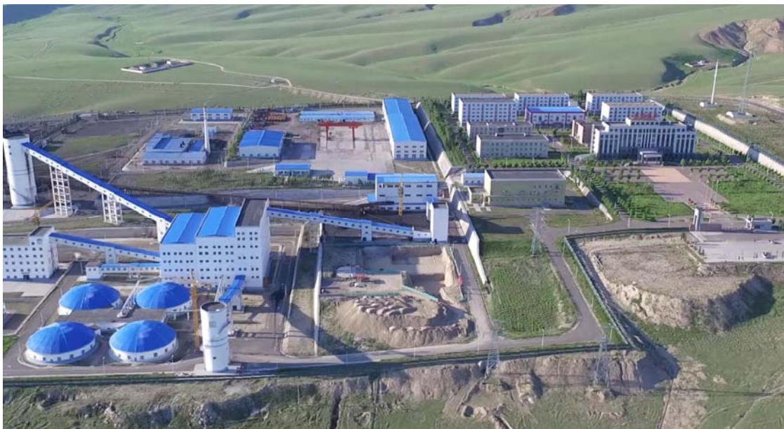
矿井工业场地
