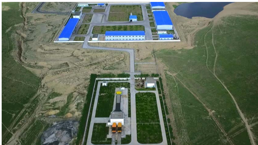
缓坡斜井场地（上）及风井场地（下）
