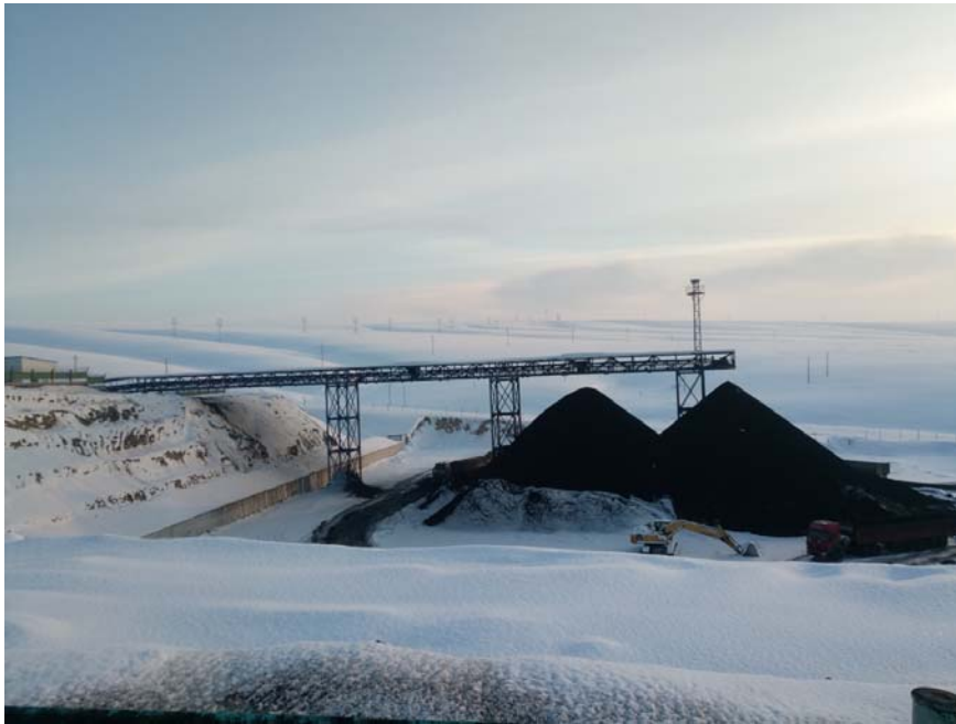
临时原煤堆场
