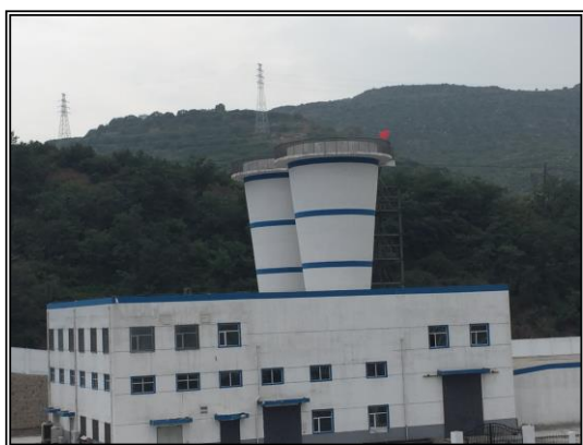
通风机扩散塔（已投用）
