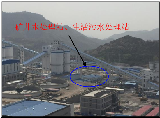
矿井水处理站在工业场地中部
