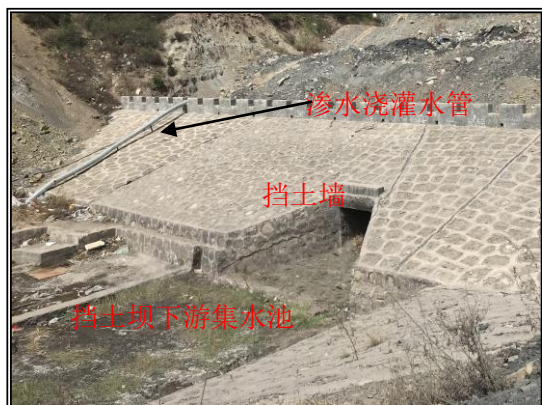
挡土墙及桩间墙工程
