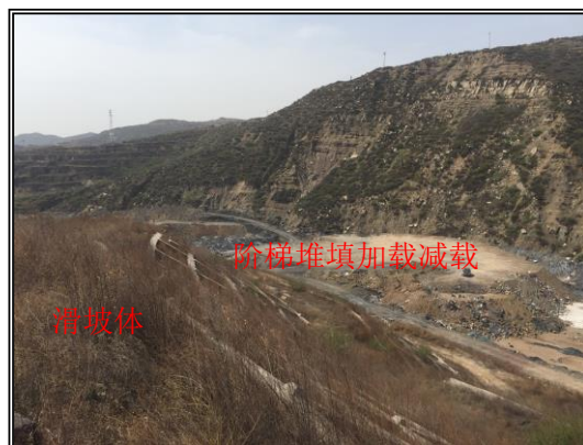
滑坡体脚部加填减载
