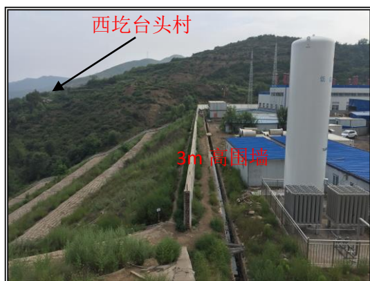
靠西圪台头村侧修建有 3m 高围墙
