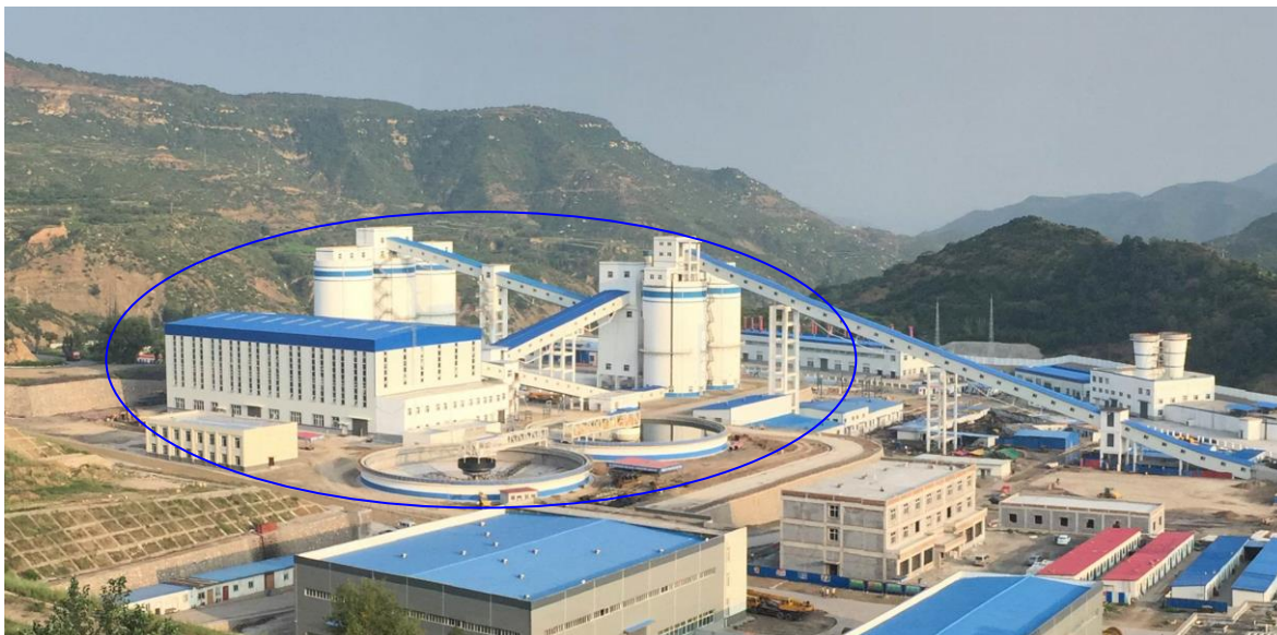
选煤厂建设现状情况
