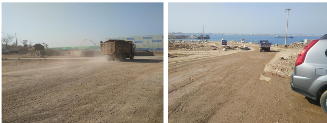
施工道路洒水前后对比
