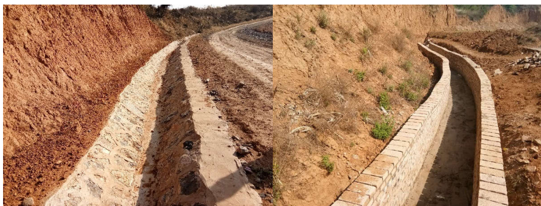
排矸场东侧截水沟 排矸场西侧截水沟
