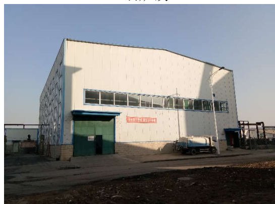
矿井水处理站
