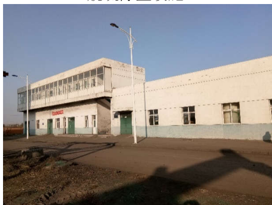
生活水处理站
