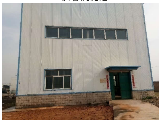
陶瓷微孔过滤器车间
