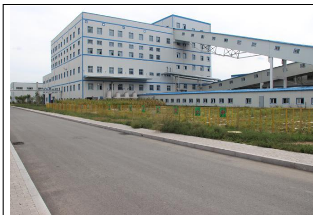
洗煤厂主厂房
