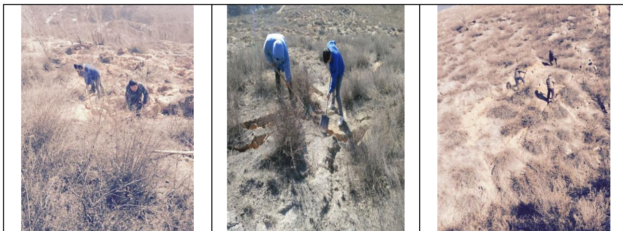
地表裂缝人工回填影像记录
