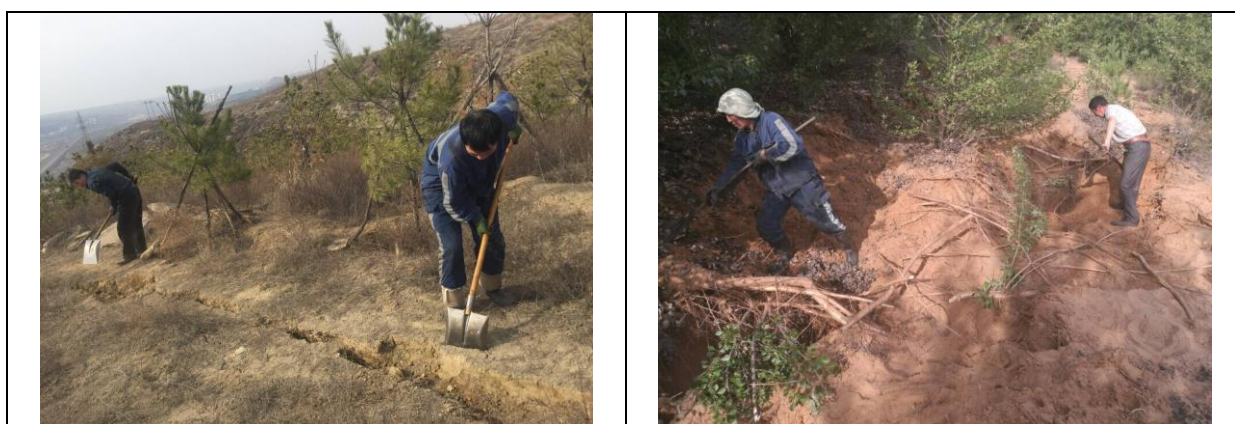
地表裂缝人工回填影像记录
