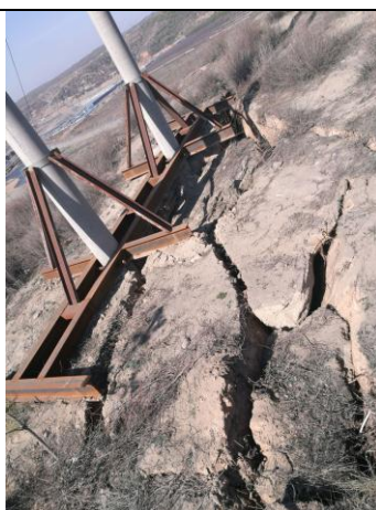
线塔加固措施
