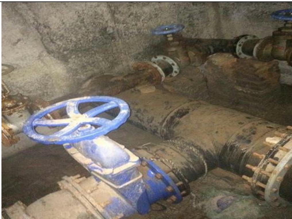
矿井与输水管线连接接口
