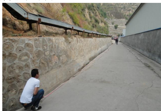
工业场地挡墙
