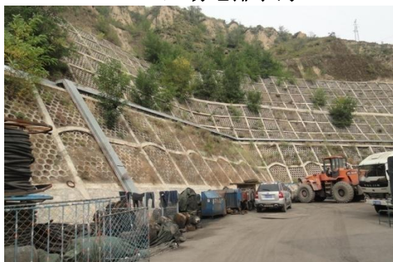
工业场地护坡
