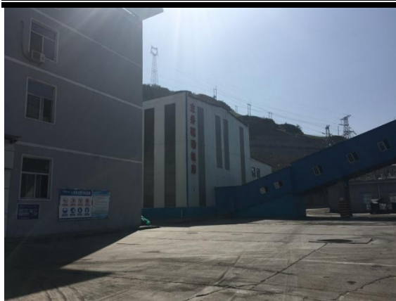
主井井口房全封闭
