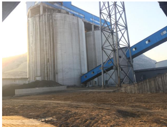
选煤厂原煤仓
