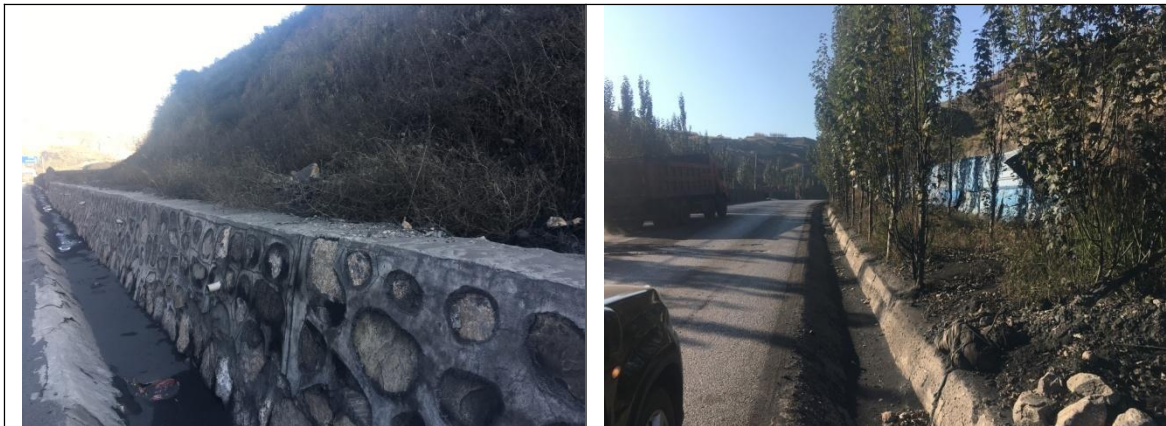
图 5-3-3 道路绿化、护坡及排水沟工程
