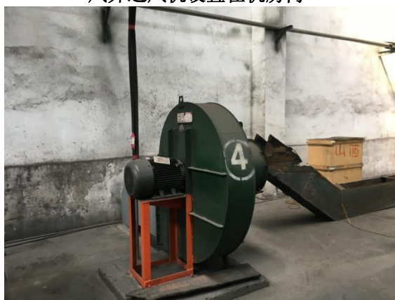
锅炉房引风机基础减振
