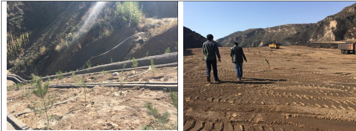
图 5-3-4 矸石场顶部覆土、边坡建设工程
