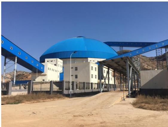
装车站圆形储煤场
