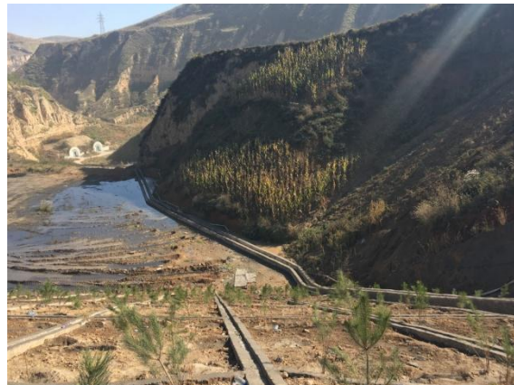
坡面绿化及排水沟
