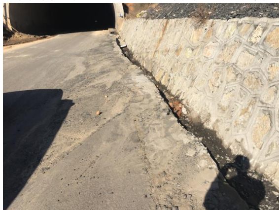
运煤道路侧排水沟
