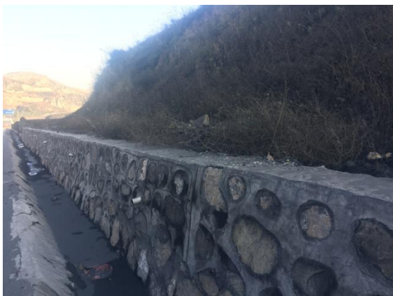
运煤道路护坡
