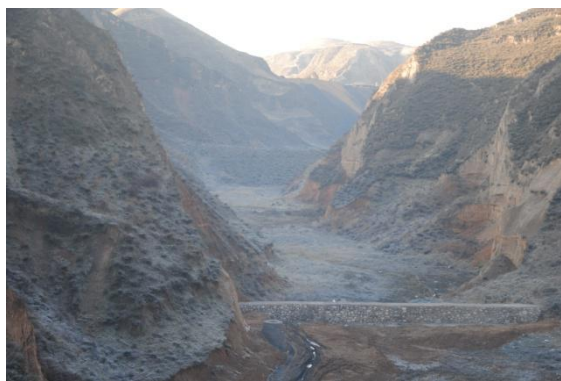
沟尾截水坝及排水涵管
