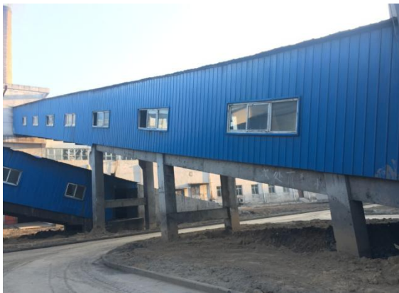
选煤厂全封闭输煤栈桥
