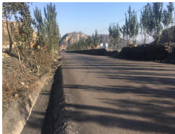
运煤道路排水沟
