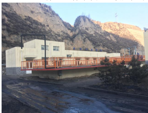
生活污水处理站
