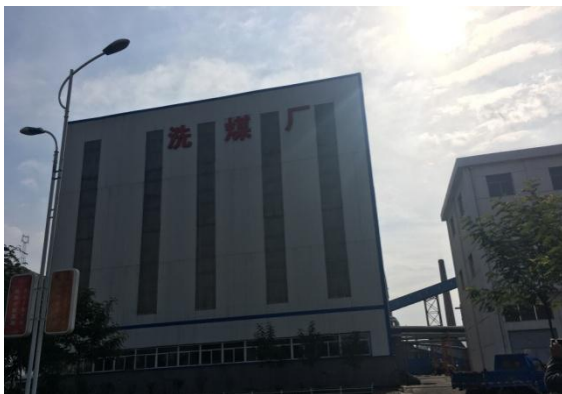
选煤厂主厂房
