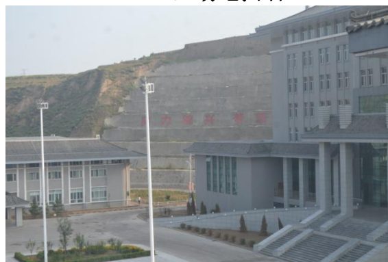
工业场地护坡
