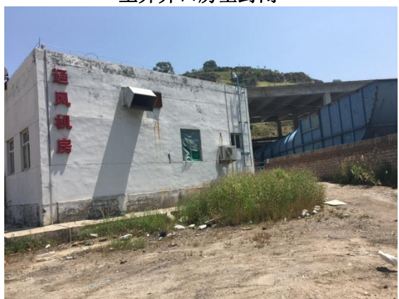
风井通风机设置在机房内
