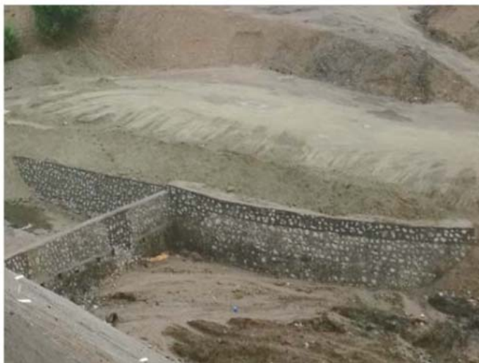
图 12.2-1 临时排矸场拦矸坝照片
