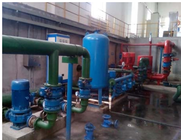
泵类基础减震
