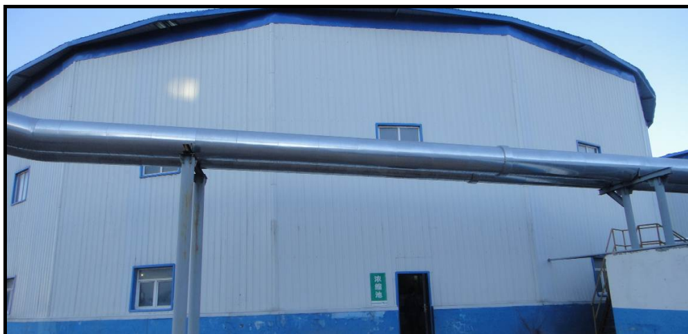
图 8.3-1 煤泥水浓缩厂房
