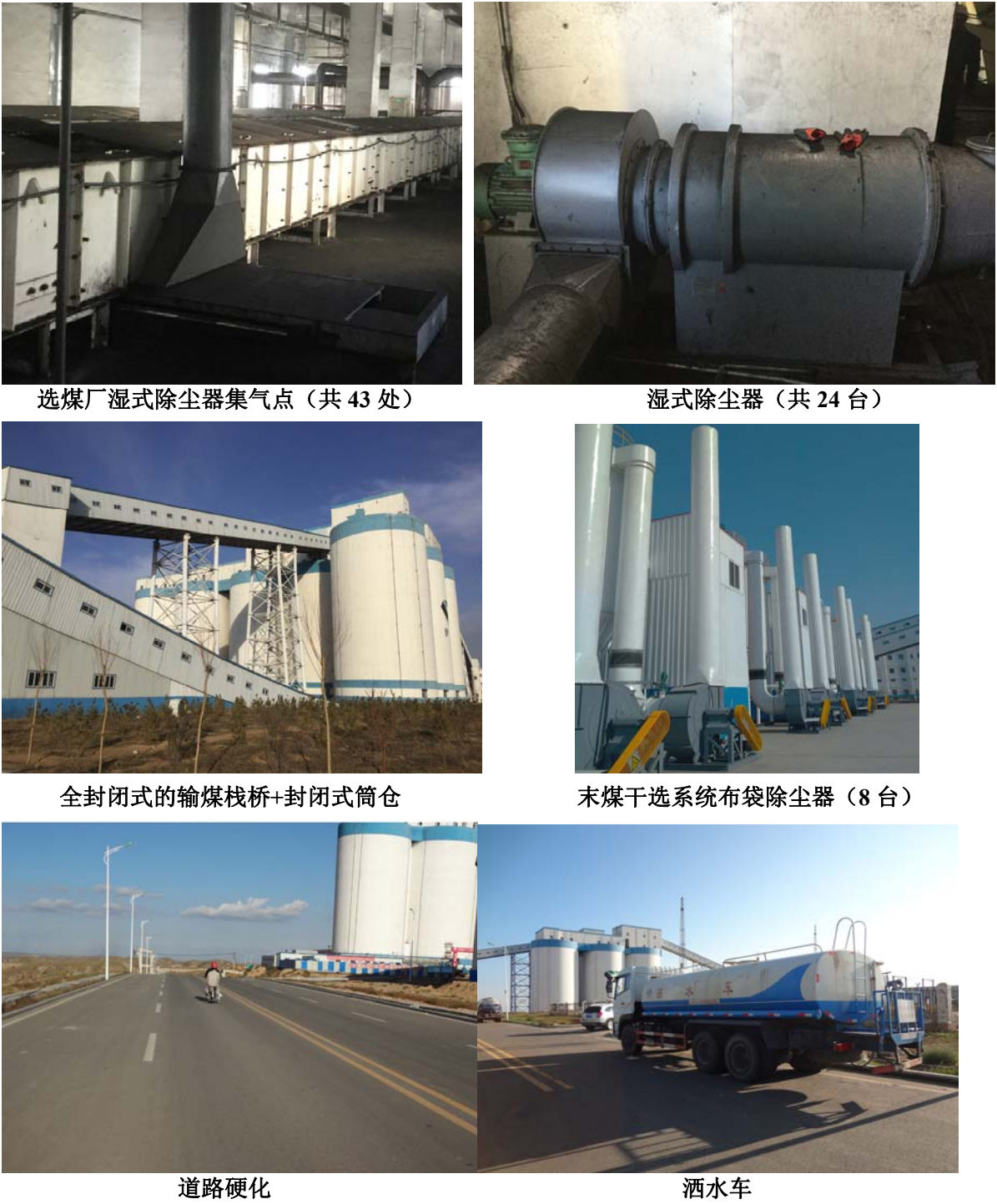
图 10.2-1 大气污染防治设施
