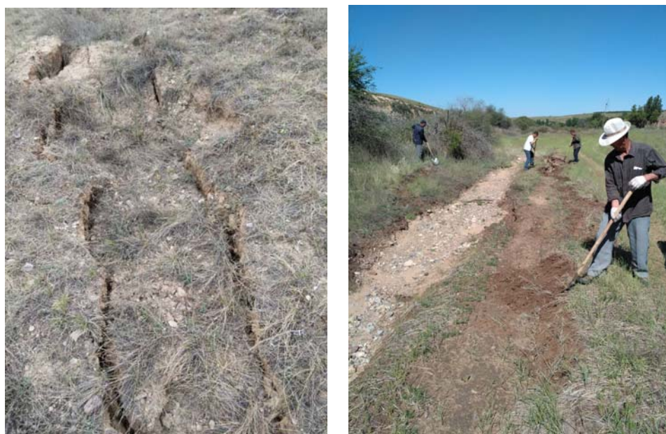
图 7.2-3 首采区地表裂缝及修复治理
