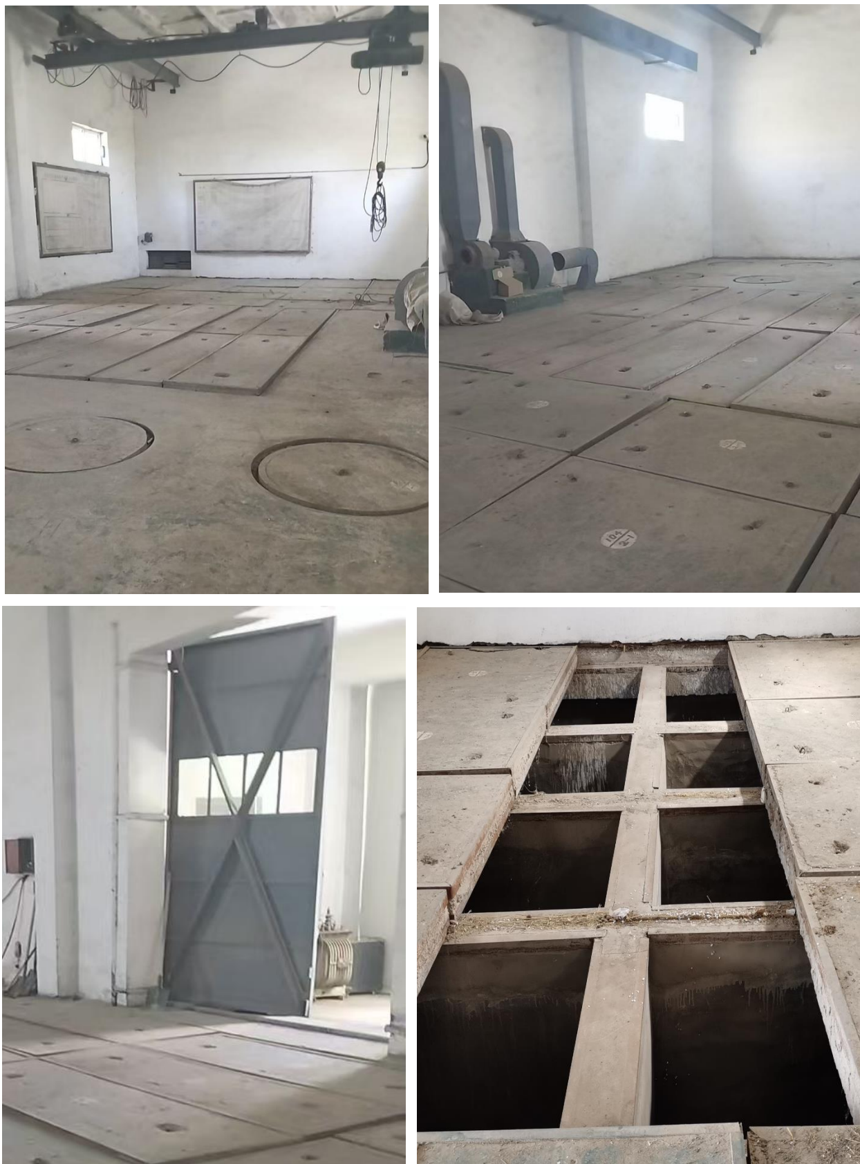
图 1-2 旧源库内部现状
