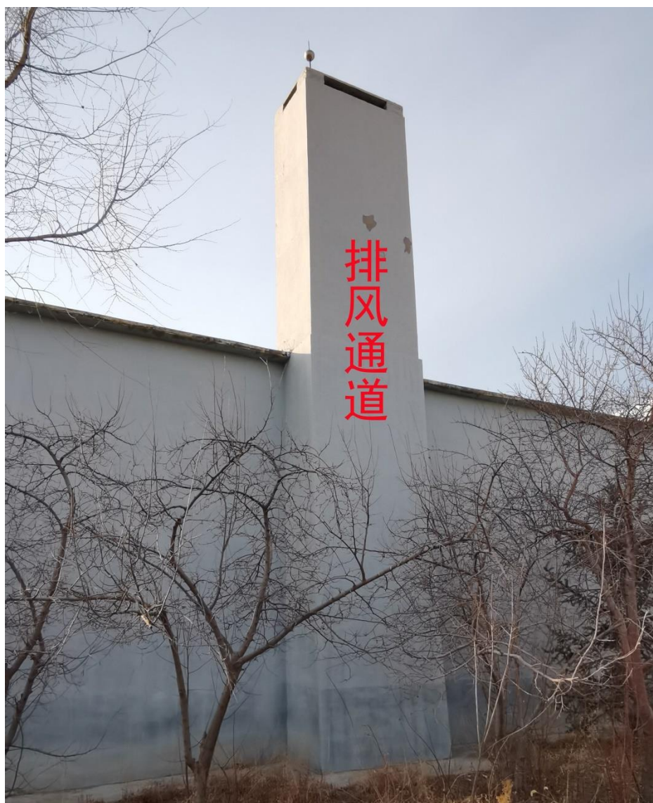
图 1-1 旧源库外观现状
