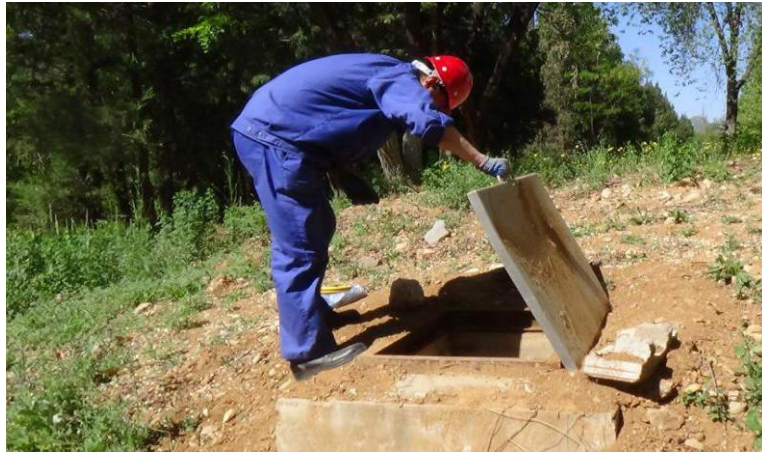
图 3.2-3 检查井排查情况
