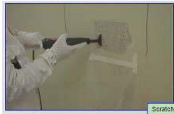
图 3.2-7 对砖砌表面进行刮取
