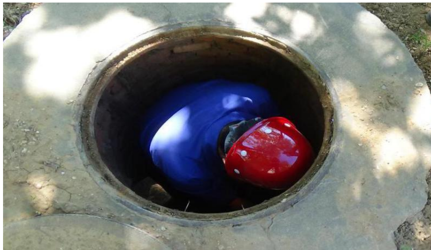
图 3.2-4 检查井排查情况
