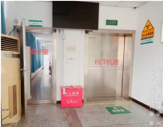
图 8-7 三层 ECT 机房现状
