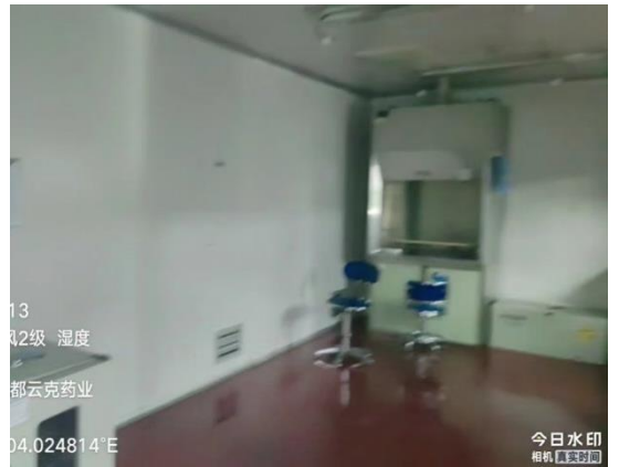
图 8-6 测量分装间现状
