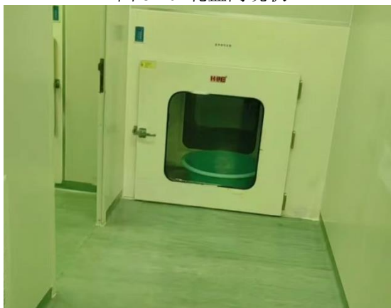
图 8-12 废弃物暂存间现状
