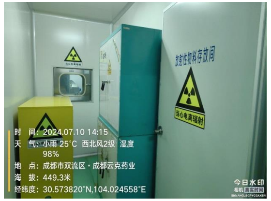
图 8-4 放射性物料存放间现状
