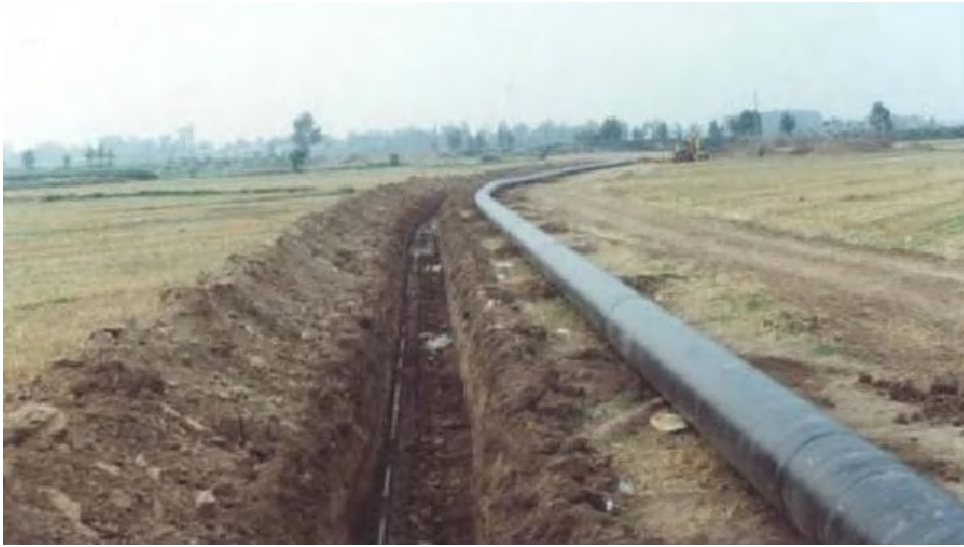
图 3.1-2 国内同类工程管线开挖实景图片
