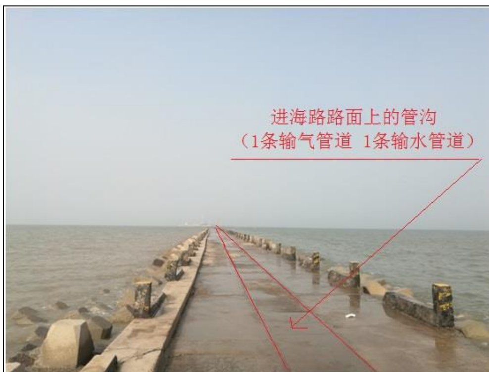
图 2.1-30b 进海路路面上的管沟（1 条输气管道和 1 条输水管道）
