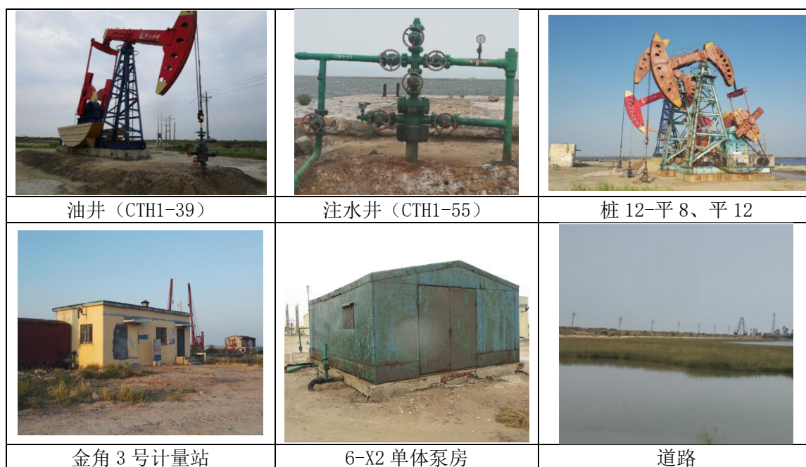
图 2.4-2 长堤油田工程设施现状照片
